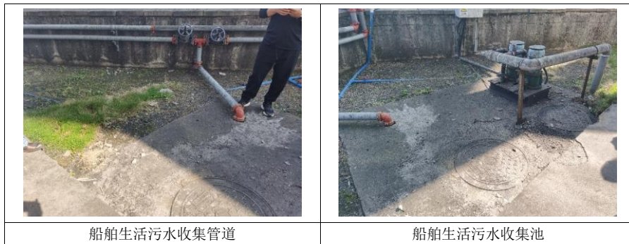
图 8.2-1 船舶生活污水收集设施现状照片
