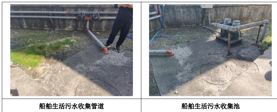
图 3.4-1 船舶生活污水收集设施现状照片
